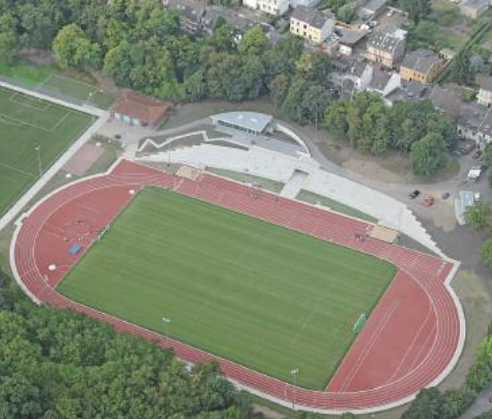
◀ Das sanierte Schlossparkstadion Brühl aus der Luft Luftbild:STRABAG Sport- stättenbau GmbH
